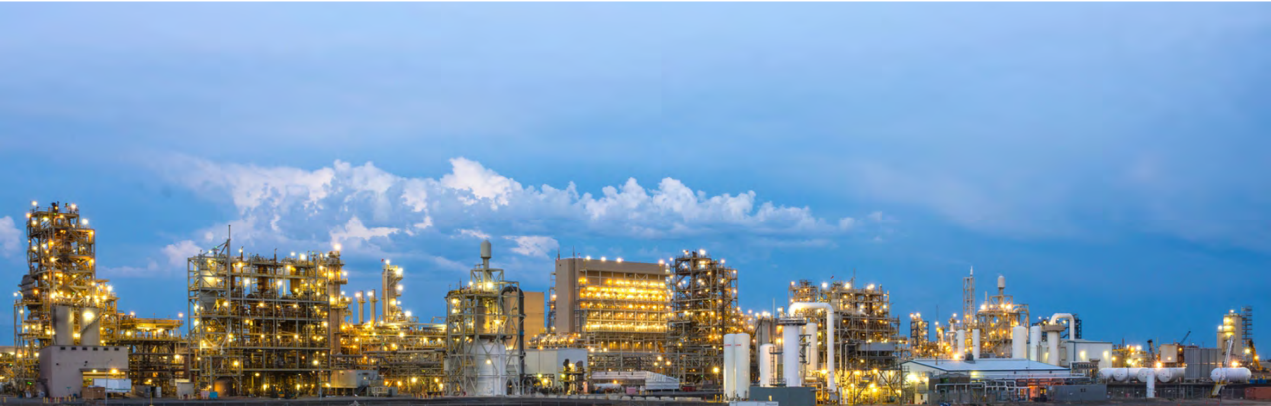
REC Silicon工厂全景
