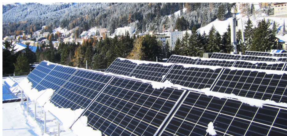
在达沃斯会议中心屋顶上安装的韩华Q CELLS太阳能电池组件
