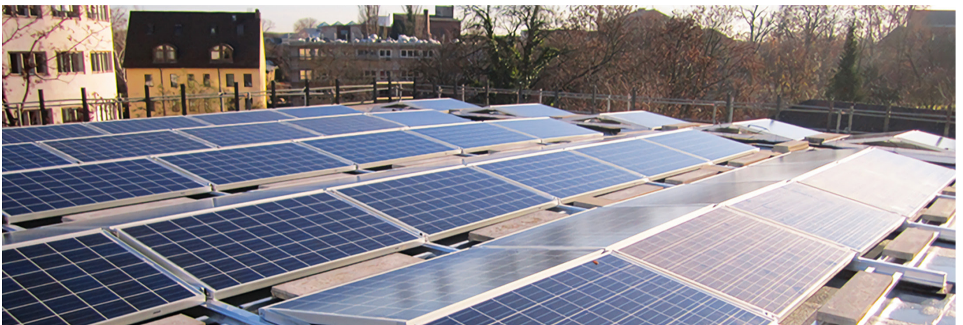
韩华Q CELLS在德国法兰克福市中心加油站安装的太阳能电池板
