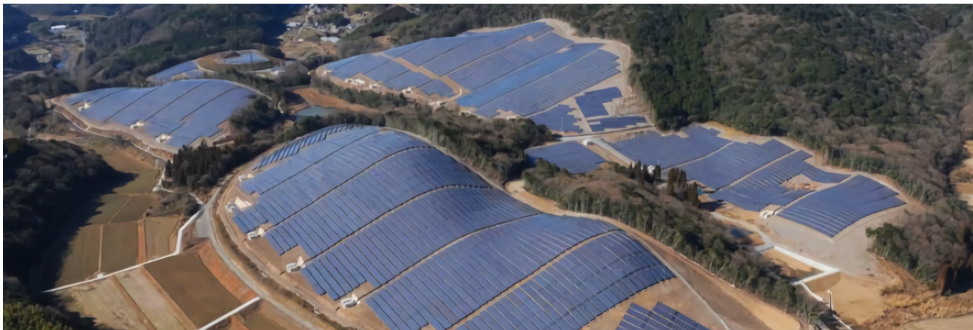
韩华Q CELLS日本公司在日本南西地区大分县杵筑市建设规模为24MW的光伏电站，可供应7000余户家庭用电
