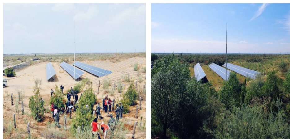
韩华集团在中国宁夏沙漠地区安装光伏发电设备培育树苗，此为全球首个依靠可再生能源植树造林的案例。
