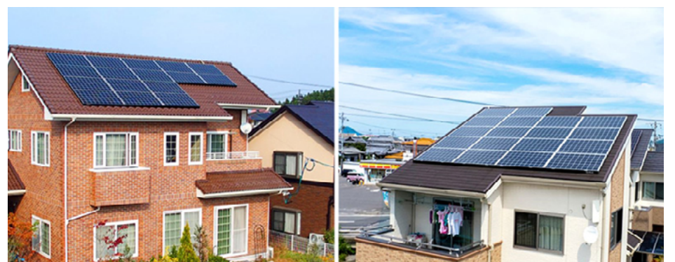
在对高度重视环境的日本，采用适合家庭使用的32片、48片Q.PEAK户用光伏组件，也能在狭窄的空间安装光伏组件
