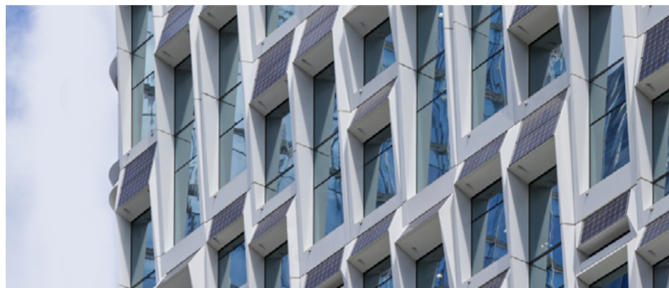
韩华大厦的一些窗户上安装了光伏模组，它的用途除了发电以外，还能保护室内工作人员免受紫外线直接照射
